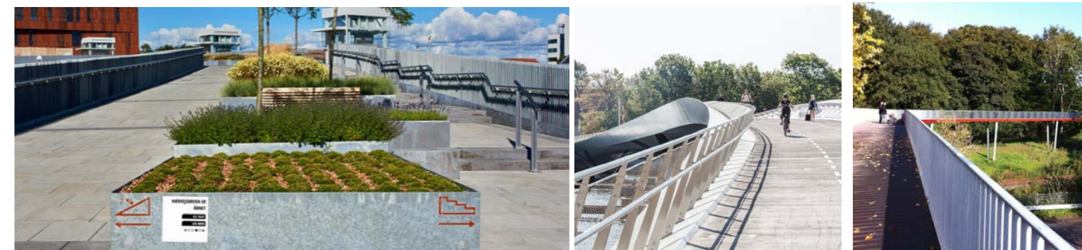
/ Eksempler på hældninger på broer i Danmark. Hhv. Hærvejsbroen 70 ‰, Lille Langebro 45 ‰ og Hjortshøj 40 ‰
