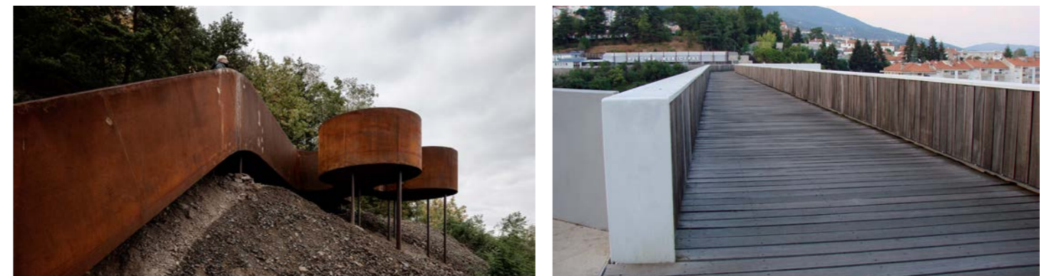
/ Et udtryk med cortenstålsplader udvendigt, og en 'træforing' indvendig på broen
