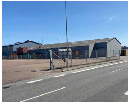
Lukkede facader og store asfaltflader
